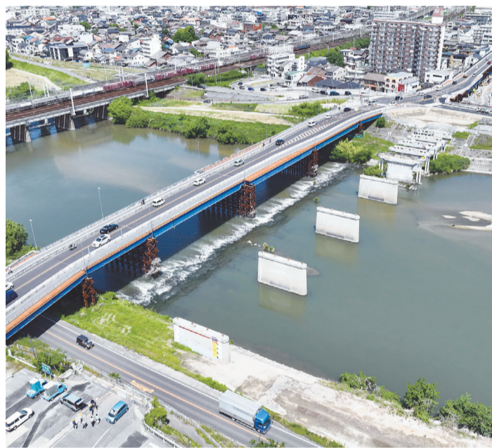
幅 円滑な交通の確保と耐震化を目的に、水分橋(橋長221.2m、幅員26.8m、3径間連
