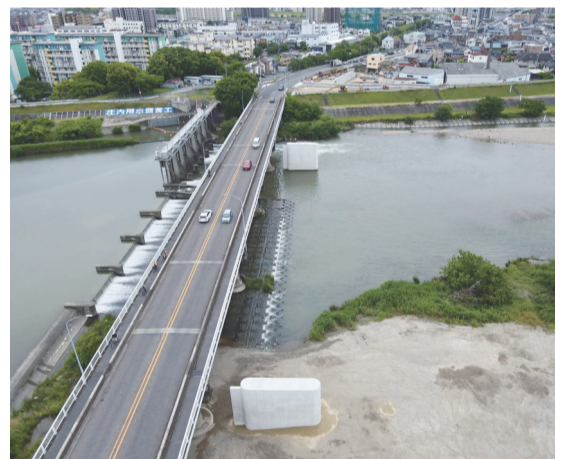
水分橋の下部工
